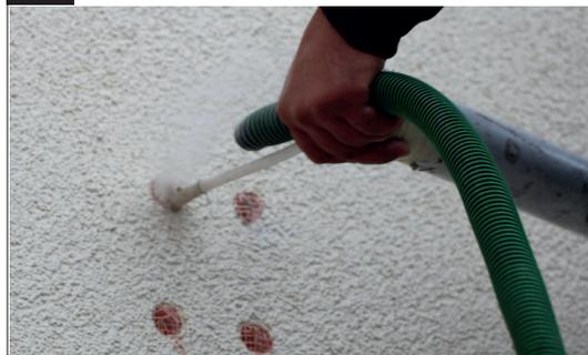
Entfernen Sie den Bohrstaub mit einer Luftpumpe aus den Bohrlöchern. Das sorgt für einen verbesserten Haftverbund.
