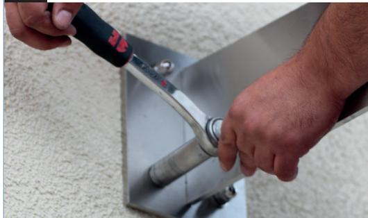
Setzen Sie die Schwerter auf die Gewindestangen und schrauben Sie diese locker fest.
